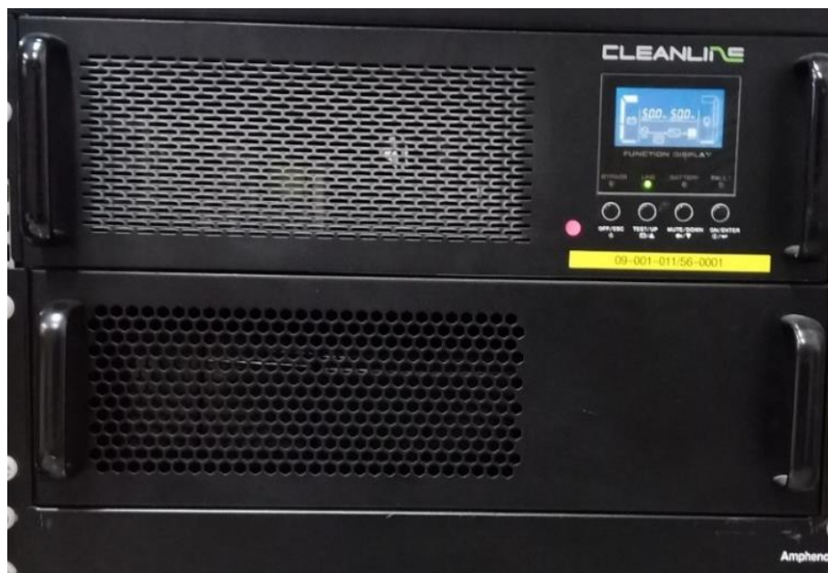
ภาพที่ 3-32 เครื่อง Uninterruptible Power System (UPS)
