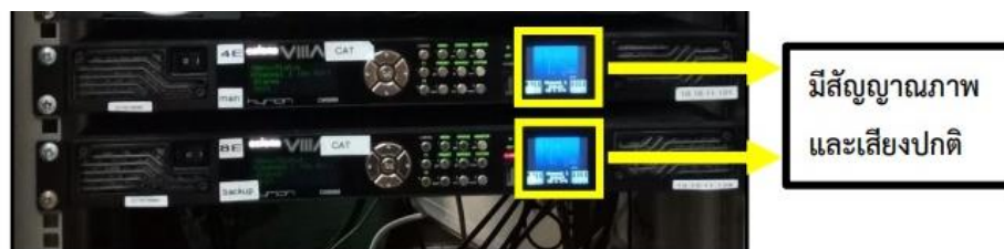
ภาพที่ 5-12 อุปกรณ์เชื่อมโยงสัญญาณภาพและเสียงผ่านเส้นใยแก้วนำแสง
